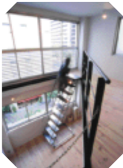
テナントビルのリノベーション。床を抜くことでメソネット・タイプに改修
