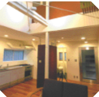
築30年の木造住宅をリフォーム。材料は余材や廃材を利用し極力コストを低減
